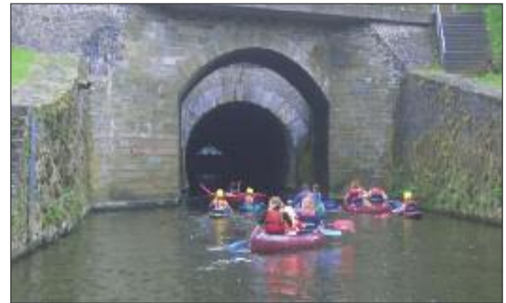
Einfahrt in den Schiffstunnel bei Weilburg/Lahn.
